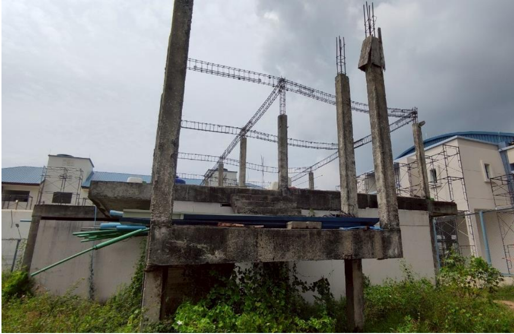
ภาพเรือนพยาบาล 2 ชั้น ขนาด 8x16 เมตร ที่ได้ดำเนินการก่อสร้างเมื่อปีงบประมาณ พ.ศ. 2560
