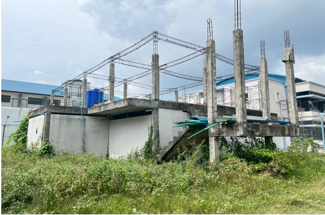
ภาพเรือนพยาบาล 2 ชั้น ขนาด 8x16 เมตร ที่ได้ดำเนินการก่อสร้างเมื่อปีงบประมาณ พ.ศ. 2560
